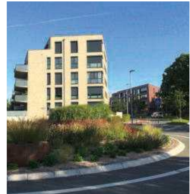
Im südlichen Bauabschnitt am neuen Kreisverkehr „Kohfurth“ wurde u.a. genossenschaftliches Wohnen realisiert
