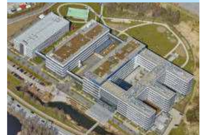
Luftansicht der Zentrale von TESA SE, am Standort Verwaltung und Forschung & Entwicklung
