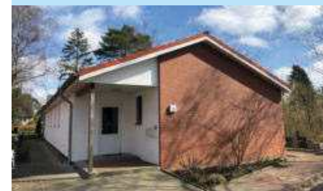
Direkt neben der Paul-Gerhardt-Kirche wurden vier sogenannte Katenwohnungen errichtet
