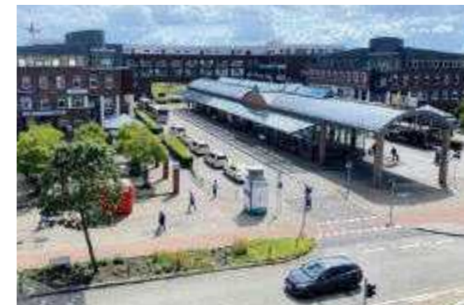
Der sogenannte Rundling am ZOB bzw. am U-Bahnhof Norderstedt-Mitte bildet einen starken städtebaulichen Abschluss
