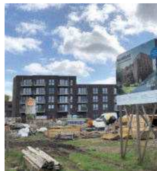
Die bisher noch unbebaute und bereits seit Jahren brach liegende Fläche wurde einer neuen Nutzung zugeführt
