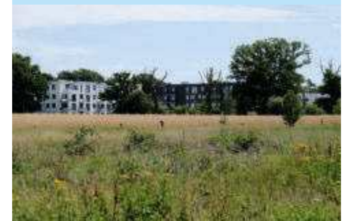
Derzeit noch nicht entwickelte Masterplangebiete im zentralen und östlichen Bereich: Vorhandene und zu erhaltende Knick- und Baumbestände sind im Masterplan vorgesehen
