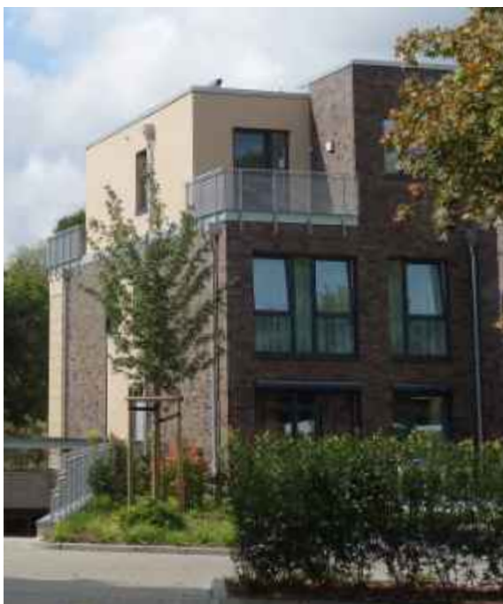
Abb. 87: Fassade mit Verblendstein und Putz (Norderstedt)
