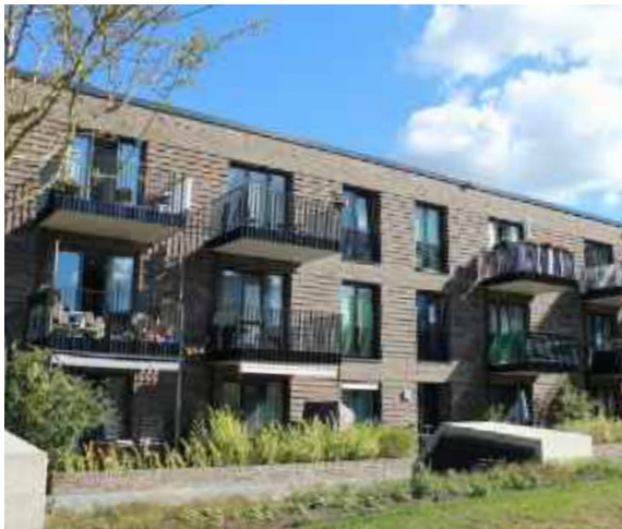
Abb. 16: Auskragende Balkone (Pergolenviertel, Hamburg)
