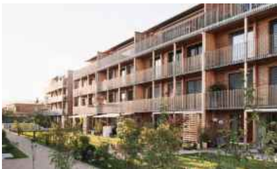
Abb. 73: Holzbauweise (Wohnsiedlung Sunny Watt, Regensdorf/CH)
