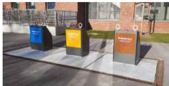
Abb. 198: Unterflurmüllsystem
