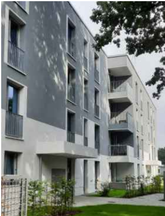
Abb. 94: Mehrfamilienhaus mit hellgrauem Putz (Friedrichsgraber Weg, Norderstedt)
