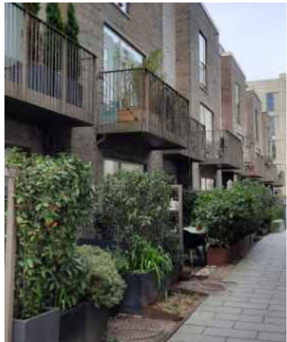
Abb. 84: Hauseingänge und Balkone (Kopenhagen)
