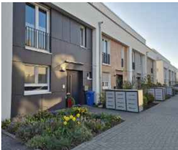
Abb. 66: Eingangsbereich Reihenhäuser (Quartier am Klosterpark, Göttingen)
