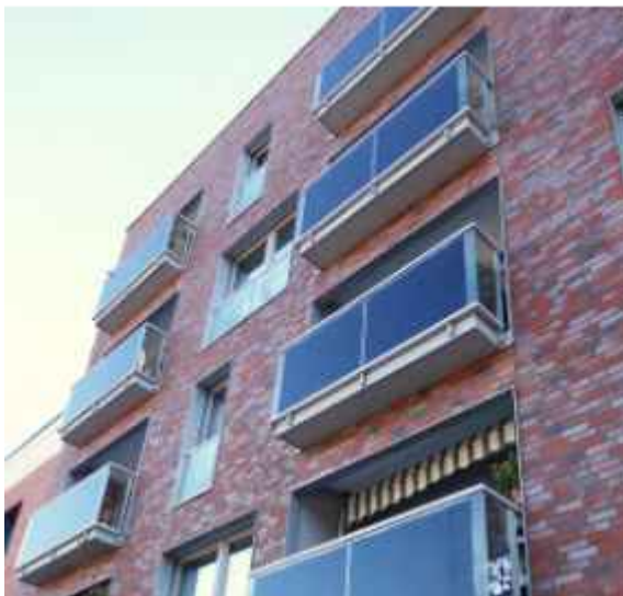
Abb. 116: Balkone mit Solarpanelen
