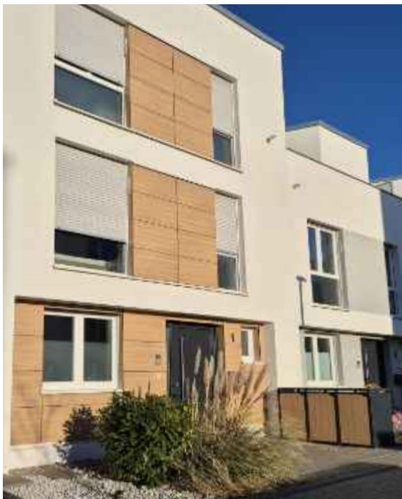
Abb. 63: Fassade mit Holzelementen (Quartier am Klosterpark, Göttingen)
