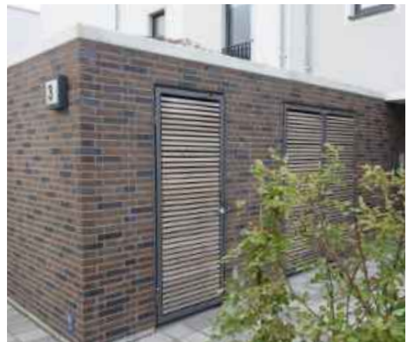
Abb. 29: Nebenanlage mit Klinkerfassade (Garstedter Dreieck, Norderstedt)
