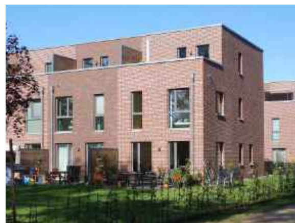
Abb. 79: Fassade mit verschiedenem Klinker (Norderstedt)
