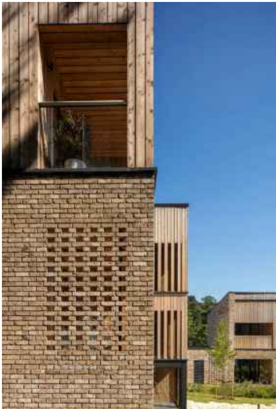
Abb. 71: Fassadendetails mit Holz und Klinker (Clockhouse Gardens, Welwyn)
