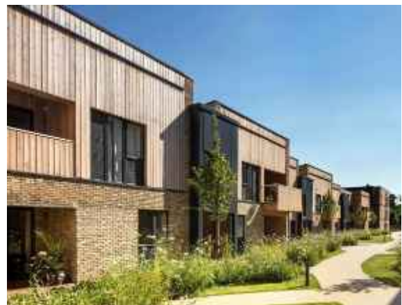
Abb. 72: Reihenhäuser (Clockhouse Gardens, Welwyn)
