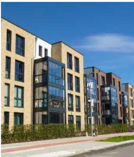
Abb. 05: Mehrfamilienhäuser mit vielfältiger Fassadengestaltung (Horst-Embacher-Allee, Norderstedt)
