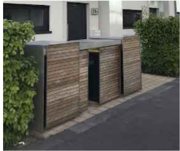
Abb. 28: Mülleinhausung mit Holzverkleidung (Hamburg)
