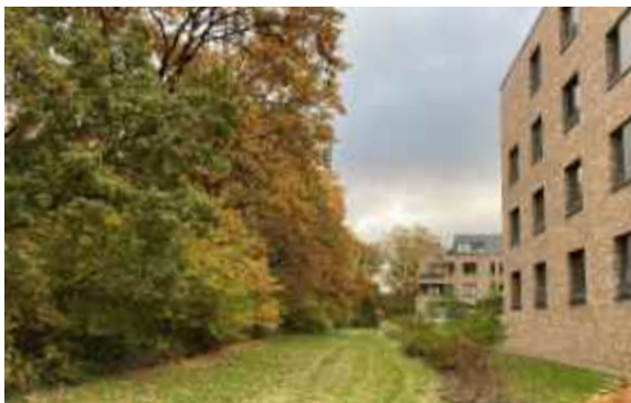
Abb. 38: Knickschutzbereich neben Wohngebäude
