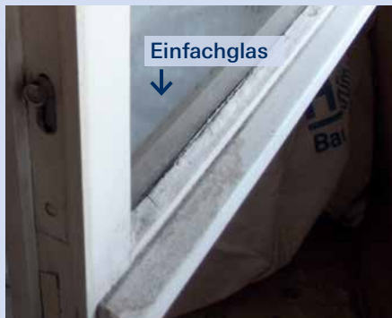
Bild 1: Fenster mit Einfachglas
