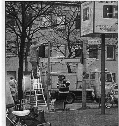
Überall in Norderstedt werden zurzeit die Ampeln auf die LED-Technik umgerüstet. Die moderne Lichtquelle hinter dem Rot-, Gelb- und Grünlicht leuchtet nicht nur wesentlich heller und erhöht so die Verkehrssicherheit. Sie ist auch sparsamer. Die Leuchtdioden verbrauchen weniger Energie und sind auch weniger anfällig für Ausfälle: Sie halten länger als die konventionellen Glühbirnen. Die Umrüstung ist für die Dauer
